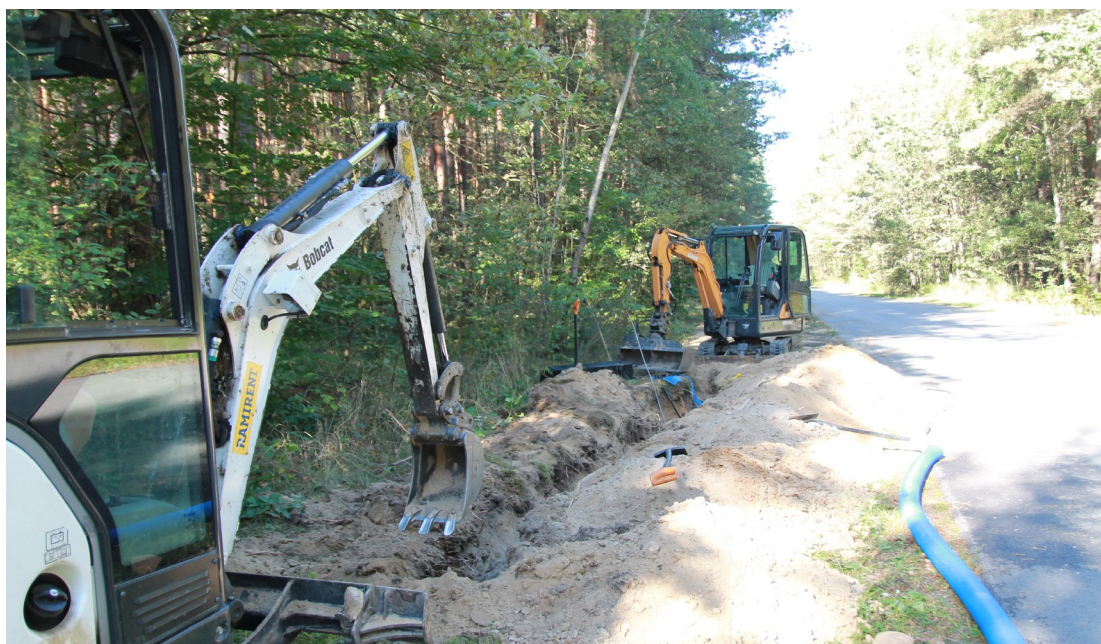
Rys. 10. Budowa oświetlenia ulicznego na terenie Gminy Ładzice.
