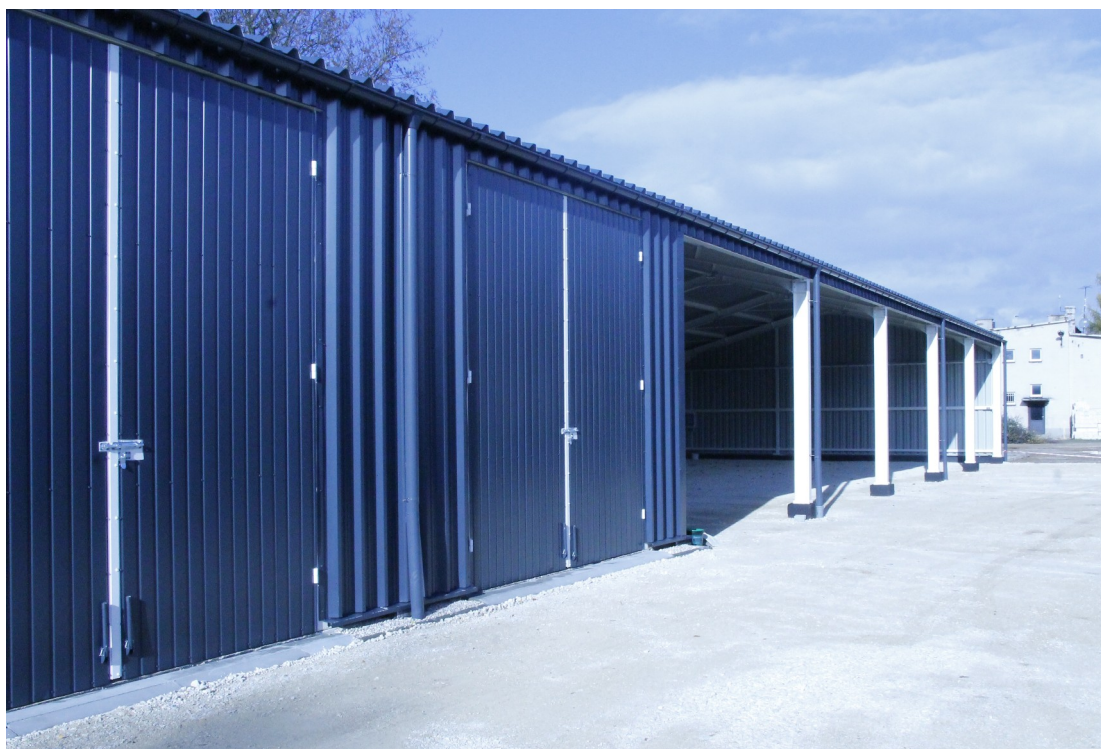
Rys. 11. Budynek gospodarczy z częścią garażową i wiatą w m. Ładzice.
