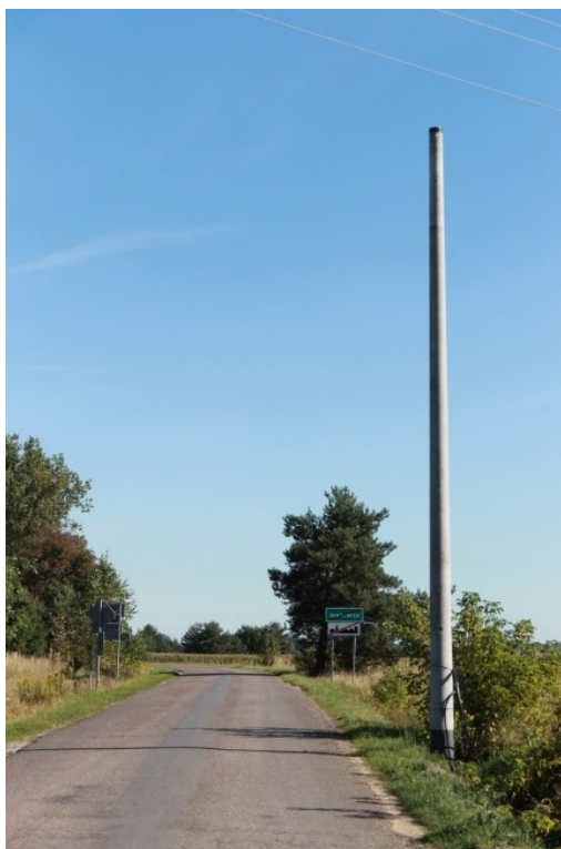
Rys. 8,9. Budowa oświetlenia ulicznego na terenie Gminy Ładzice.
